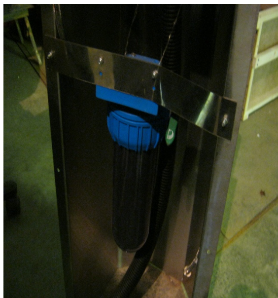
Фильтр фонтанчика наполнен шунгитом
